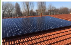
**Tecnologia proposta:** Impianto fotovoltaico completo di Inverter costituito da pannelli monocristallini, dimensionato per i fabbisogni comuni (ascensore, luce scale, impianto centralizzato, ...)
