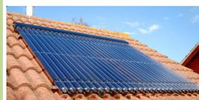
**Tecnologia proposta:** Impianto solare a circolazione forzata costituito da pannelli sottovuoto e sistemi di accumulo fortemente isolati per:
