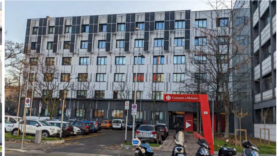
SERRAMENTI FACCIATA OVEST (VIA DURANDO) - POST OPERAM
